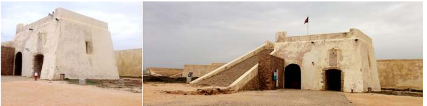
❶ Cuerpo central con la entrada. ❷ Este cuerpo reconstruido por José de Sande Vasconcelos en 1793, coronel de ingenieros, sustituyó al torreón de entrada construido durante el reinado de Felipe II (1581-1589) Tenía por objeto la defensa de la puerta principal.
