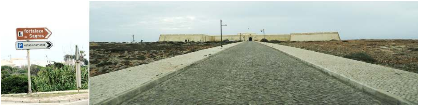
❶ Conviene estacionar el coche antes de llegar en los parquin. ❷ Panorámica del acceso hasta la puerta principal.
