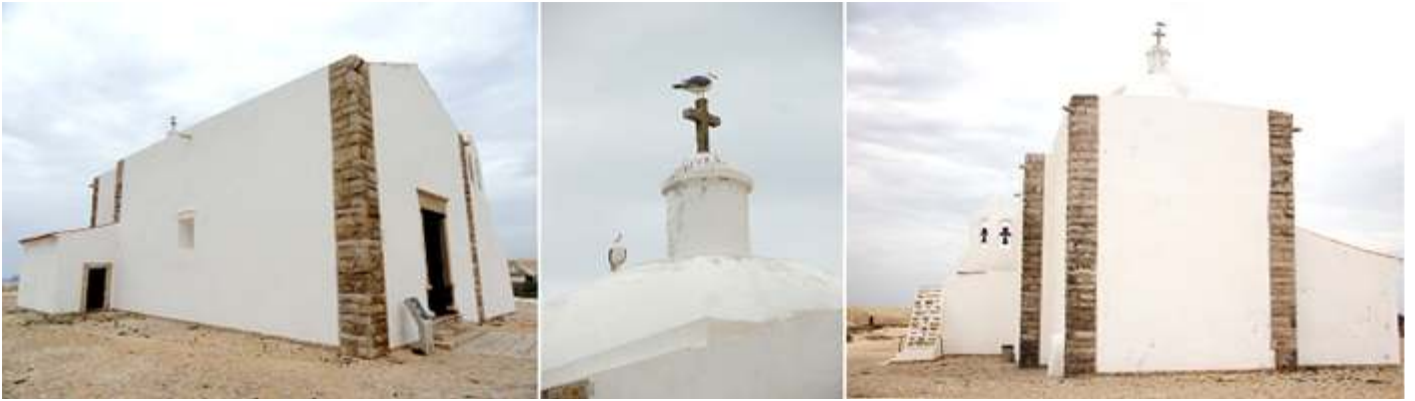
❶ Lateral del Evangelio con la sacristía adosada al mismo, ❷ Cúpula de la capilla Mayor. ❸ Y su testero recto, toda ella lucida de blanco salvo sus ángulos en piedra vista.
