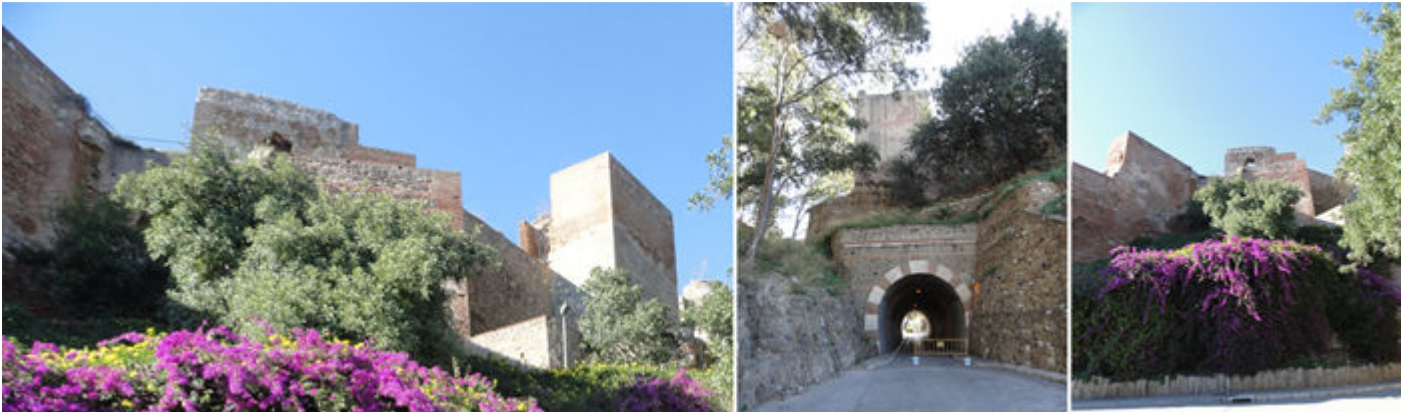
❶ A mano derecha la Torre Mayor que posee un sistema de recogida de aguas. ❷ El túnel. ❸ Lienzos de las murallas entre la exuberante vegetación de las buganvillas.
