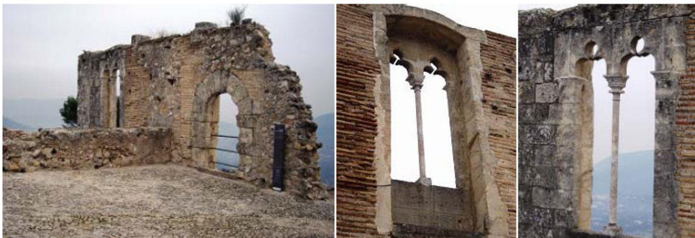
❶ Sala del Duque de Calabria. ❷ En un lienzo queda esta doble ventana parte interior. ❸ Con arquillos trilobulados y con un fino mainel.
