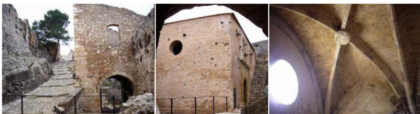
1 Puerta de Santa María, llamada así por la proximidad a la Capilla Mayor del Castillo. 2 Perspectiva de la misa con un óculo en el muro lateral. 3 Crucería del techo de la capilla con una clave decorada. En los dinteles están los escudos de Aragón.
