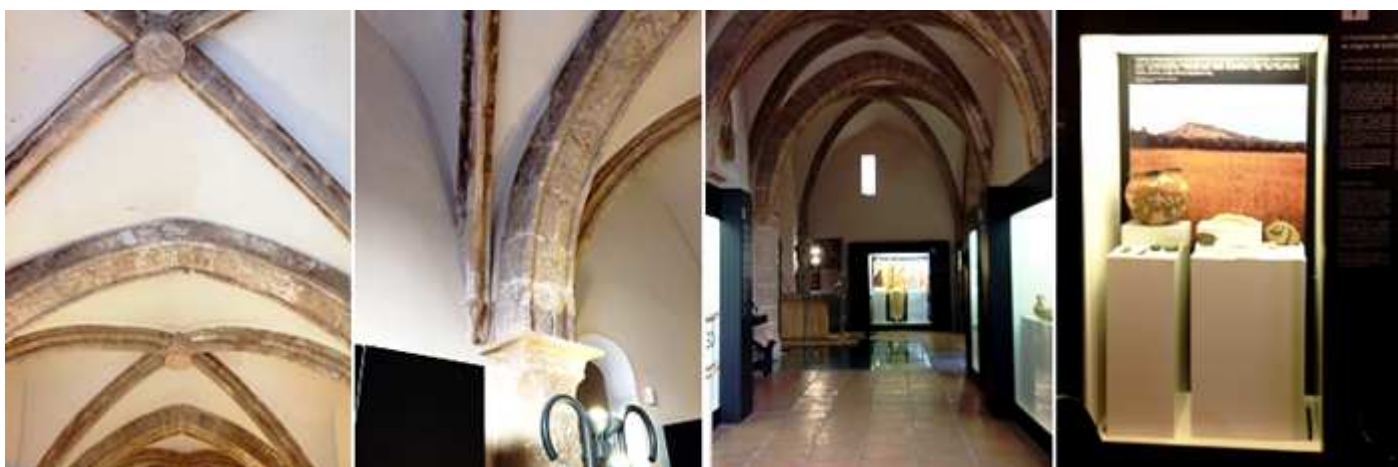
1 Detalle de los nervios y claves de la crucería de la capilla del castillo. 2 Los arcos fajones y nervios parten de ménsulas laterales. 3 La otra parte del tramo de L que forma parte de la capilla. 4 Otra de las vitrinas con el origen del castillo.
