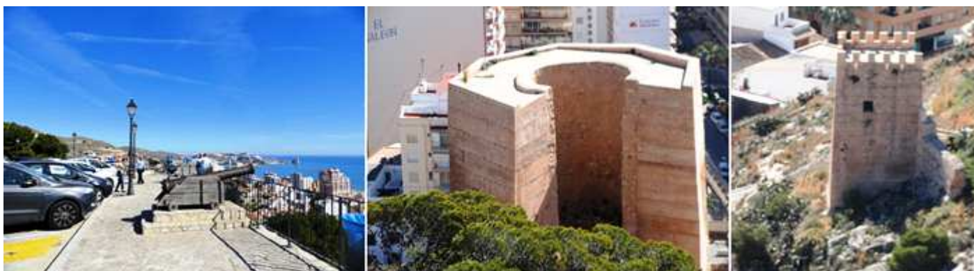
❶ Aparcamiento. ❷ Torre Octogonal. ❸ Torre del Raco de San Antonio, ambas en la ladera bajo el aparcamiento.
