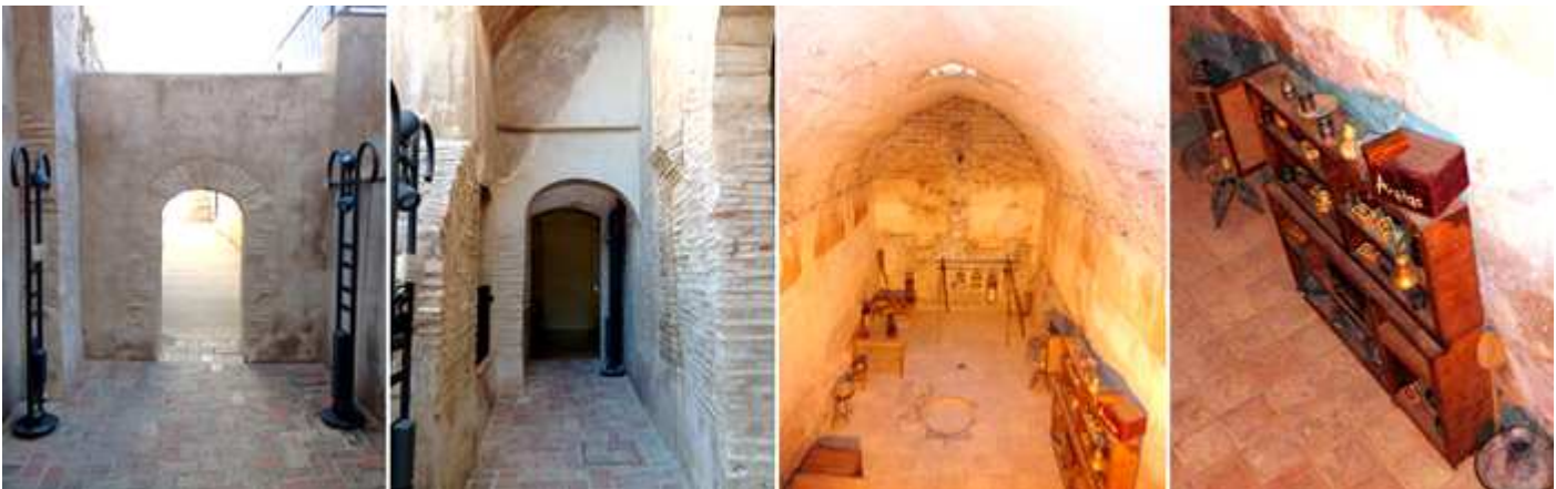
❶ Rampa que baja de la plaza de armas. ❷ Pasillo a las cisternas. ❸ Las cisternas de origen árabe que abastecían de agua a la fortaleza captada por los tejados los días de lluvia. ❹ En ellas se aprecia la notable altura que disponían para almacenar agua.
