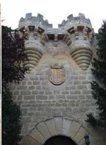
1 Puente de piedra elevado con una rampa en forma de L. Y entramos con un grupo. 2 Sobre la puerta dos matacanes redondos. Y el escudo del Duque de Lerma. 3 Y esta está construida con grandes dovelas lisas y custodiada, con dos guerreros de piedra.
