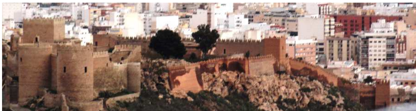
1 La alcazaba cuenta con un perímetro amurallado de 1.430 metros.
