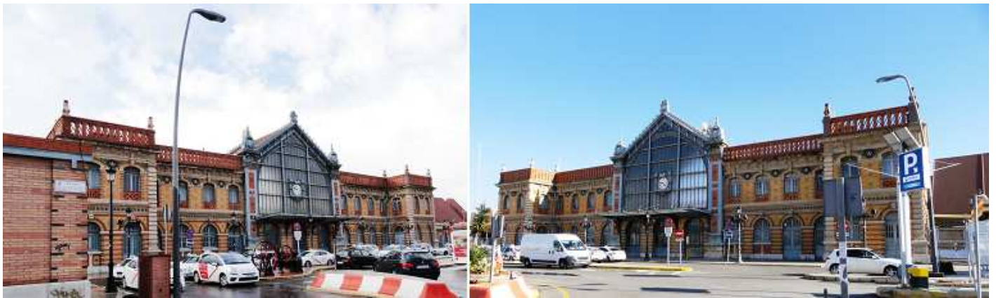
1 Fachada estación ferrocarril. 2 En el año 1892 comenzó la construcción de esta estación para la Compañía de los Caminos de Hierro del Sur de España. Es un símbolo de modernidad de finales del S. XIX. Su cuerpo central está diseñado en hierro, lo que le confiere una ligereza y esbeltez a la fachada.
