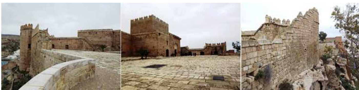
❶ Lienzos exteriores. ❷ Patio de armas del tercer recinto. ❸ Torreón junto al palacio de Al-Mutasin que estaba en la parte inferior del mismo.
