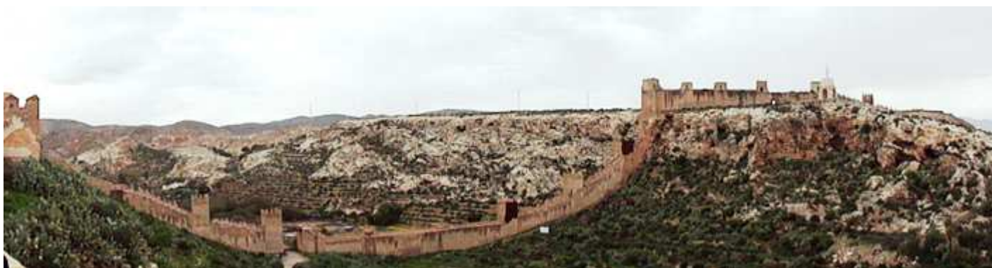
1 Panorámica de la muralla de Jairán sobre el barranco de la Hoya.
