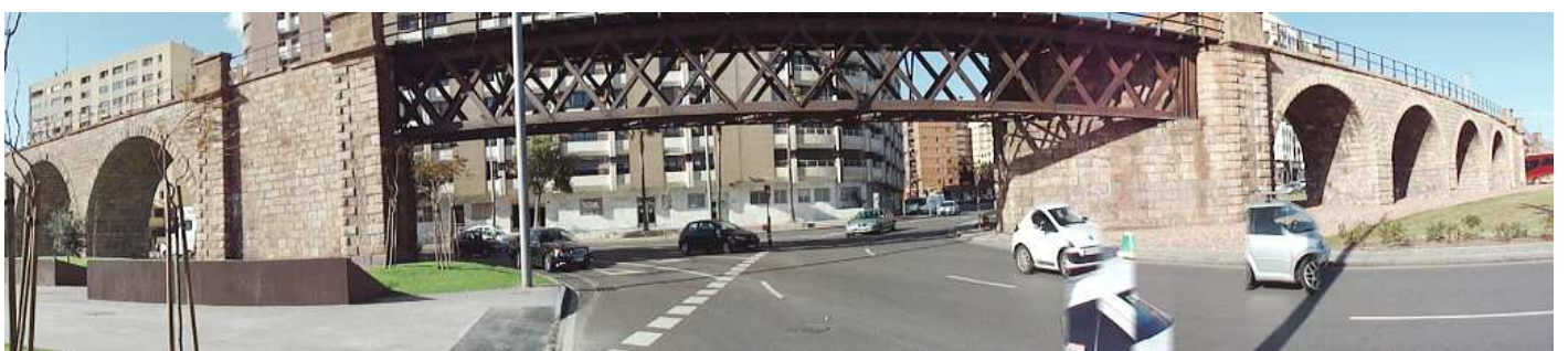
1 Acueducto del Cable Inglés
