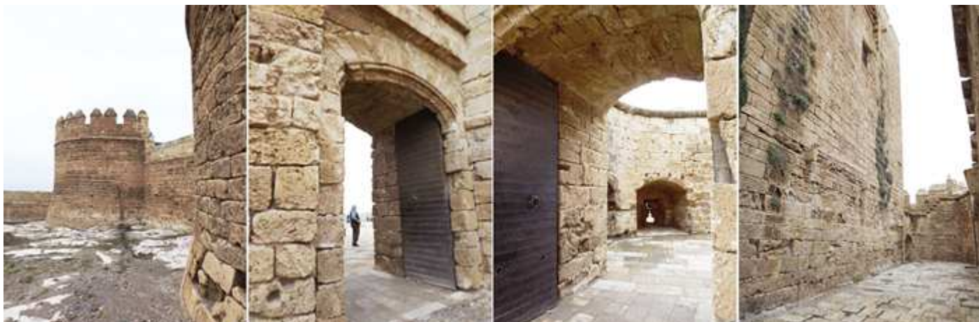
❶ Lateral de la fortaleza. ❷ Puerta de acceso al patio de armas. ❸ AL fondo una de las torres semicirculares. ❹ Lateral de la torre del homenaje.
