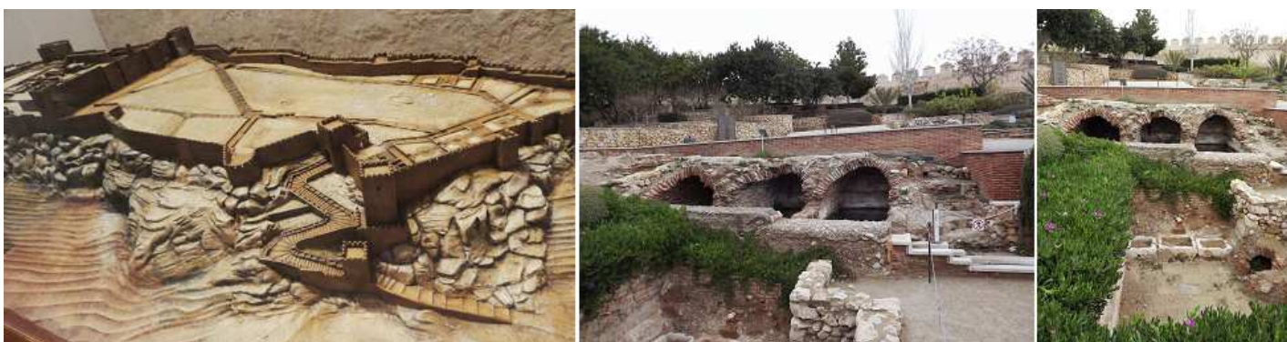
❶ Maqueta de la alcazaba. ❷ En la parte central de esta zona se encuentran los aljibes que eran alimentados por una noria de 70m, que estaba en el tercer recinto. ❸ En los aljibes se decantaba el agua que pasaba a la fuente.
