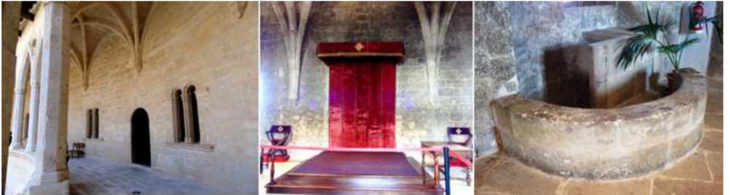
❷ Recorremos la galería entrando en lo que era el Salón del Trono. ❸ Cabecera del Salón del Trono. ❹ Espacio de una escalera de caracol desde el piso inferior.
