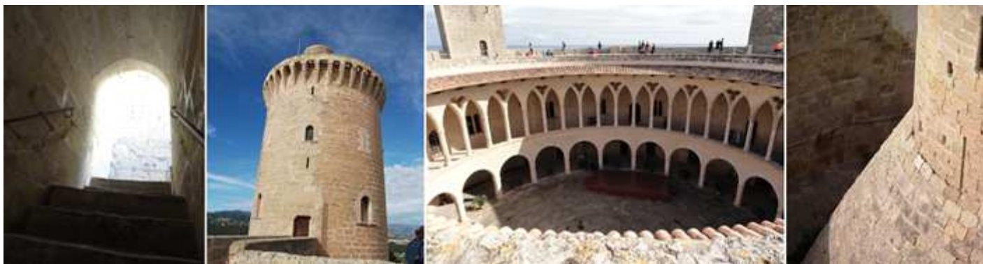
1 Accedemos a la azotea del castillo donde proporciona unas vistas inmejorables. 2 La torre del homenaje. 3 Vista del Patio de Armas. 4 Y otro de los fosos junto a una torre.
