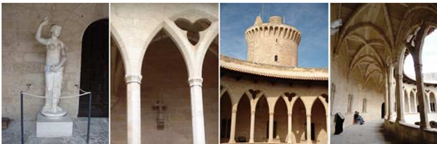
❶ Una estatua de Venus. ❷ Detalle de la arquería de la segunda planta. ❸ Al fondo uno de sus torreones redondos. ❹ Galería con arcos de cruceira que arrancan de ménsulas y de los arcos de las ventanas apuntadas.
