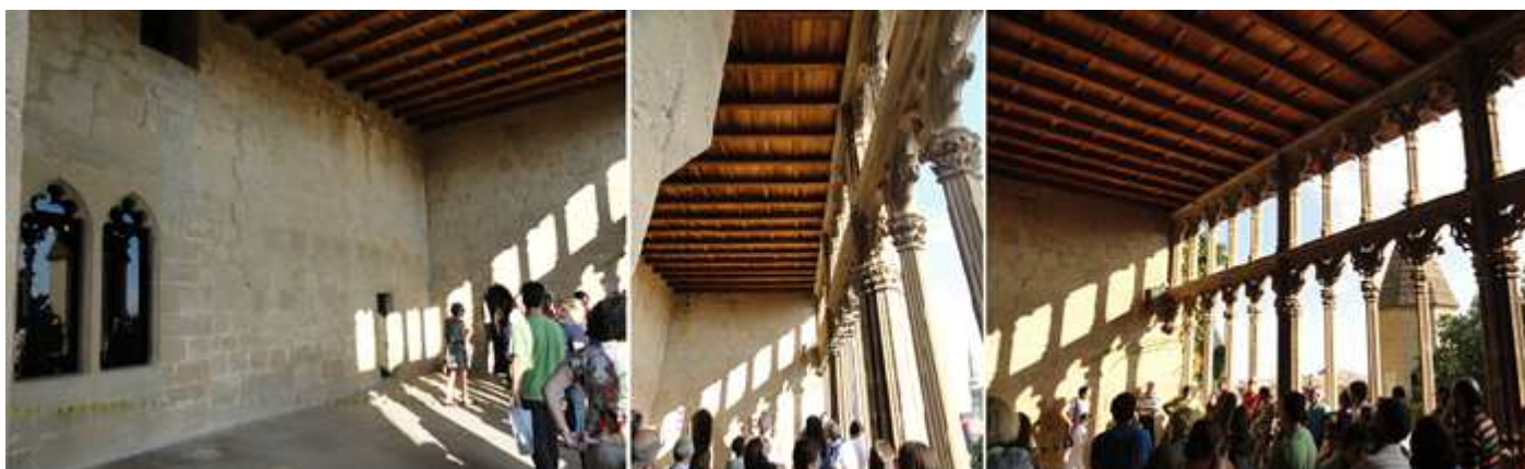
❶ Lateral opuesto a la arquería del mirador con dos ventanas. ❷ Las finas columnillas. ❸ De los arcos trilobulados.
