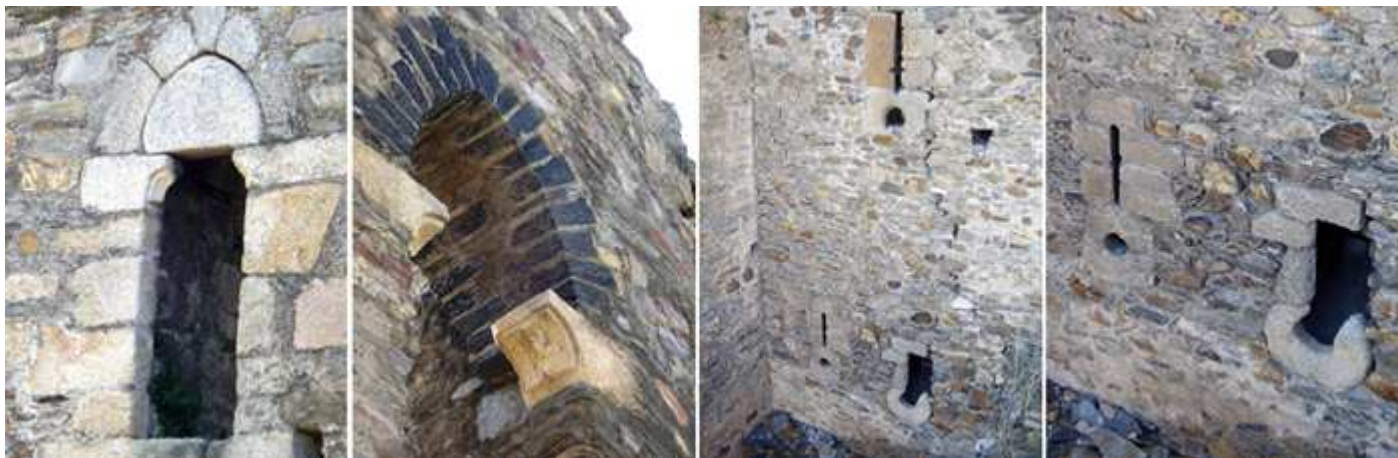
❶ Una ventana del espacio anterior que en su arco apuntado sobre dos mochetas dispone de un tímpano liso ❷ Otra ventana sin tímpano y con unas mochetas similares. ❸ Muro junto a la Torre del Homenaje (izd a ) de 1340 está el muro de la torre de los Reyes Católicos (1486-1504). ❹ Y en la parte inferior posee una tronera de esta época.
