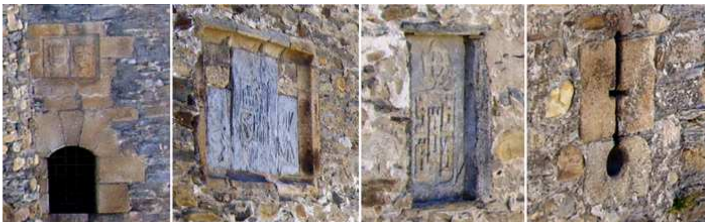
❶ Escudo del cubo Nuevo, previsible de Pedro Álvarez de Osorio que fue el que levanto el mismo ❷ Siguiendo por el adarve se encuentra la Torre de los Reyes Católicos, estos son sus escudo. ❸ Escudo inferior no identificado. ❹ Aspillera de palo y orbe.
