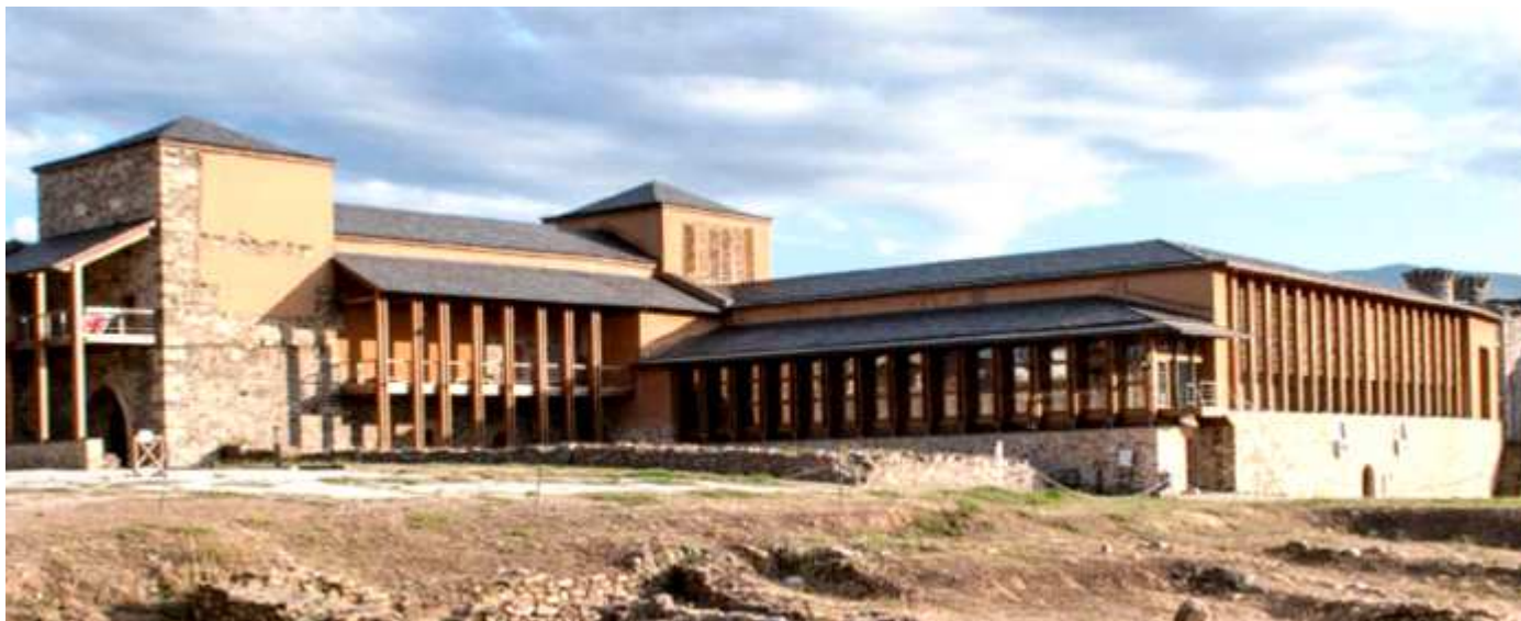
❶ Instalaciones rehabilitadas en el castillo Nuevo, donde se encuentra el patio con la sala de armas.... Foto de la guía del Castillo.
