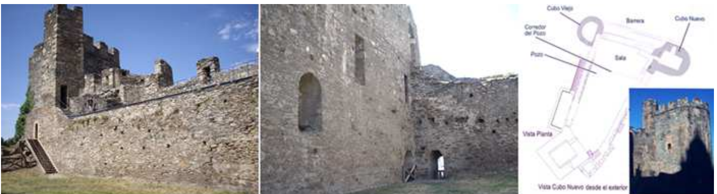
❶ Exterior del corredor del patio del castillo Viejo. ❷ Los paramentos que conserva en su interior. Donde hubo un edificio de tres plantas y un corredor o galería de madera ante su fachada. ❸ Croquis de un cartel informativo que nos aporta como era su planta. Y la imagen del cubo nuevo realizado en el mismo y que hemos visto en el exterior junto a la calle Gil y Carrasco.
