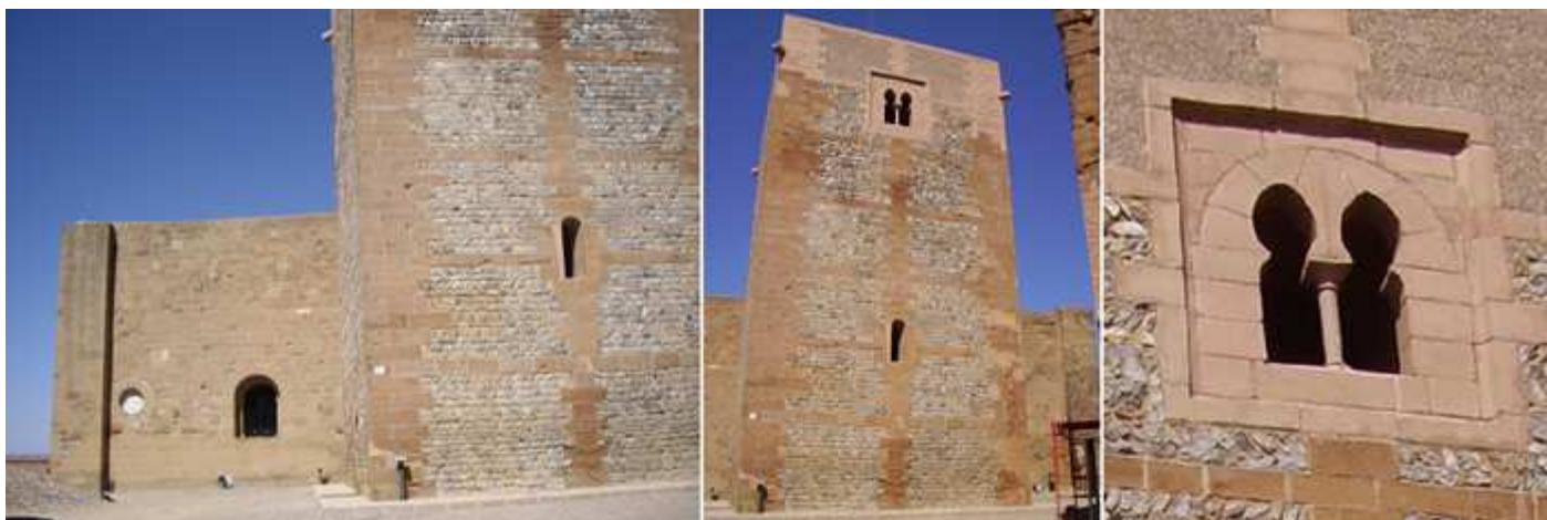
❶ La Sala Capitular al fondo y la parte baja de la torre del homenaje de frente. ❷ Lateral de la Torre del Homenaje su construcción data de los S. IX-X. ❸ Ventana dotada con dos arcos estrechos de herradura con una columnilla.
