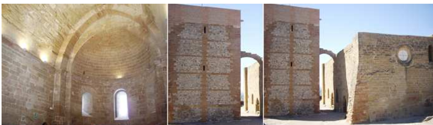
❶ Cabecera con el arco triunfal y la bóveda de horno, abierta con tres ventanas con derrame. ❷ Lateral este de la torre del Homenaje ante el patio de armas. ❸ A su derecha la sala Capitular y refectorio.
