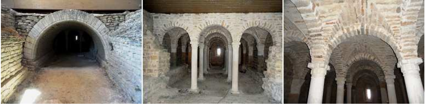
❶ A través de este arco de medio punto se accede a la cripta. ❷ La Cripta está compuesta a su vez con tres naves siendo las laterales separadas y cubiertas con bóveda de cañón. ❸ En la central dividida a su vez por tres naves con 16 columnas.
