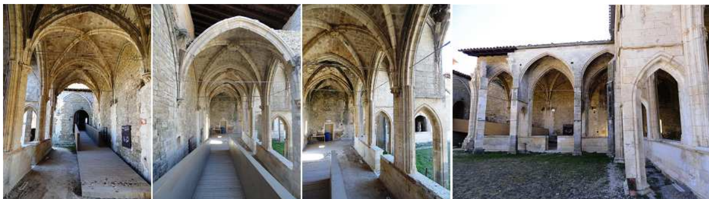
1 Nada más entrar se accede al claustro y giramos a la izquierda si entramos en el templo y a la derecha al ala norte. 2 Esta pasarela esta adosada al templo 3 El ala que da al sur del claustro con arcos apuntados y bóvedas de crucería. 4 La panda del sur y la del oeste desde el patio interior del mismo.
