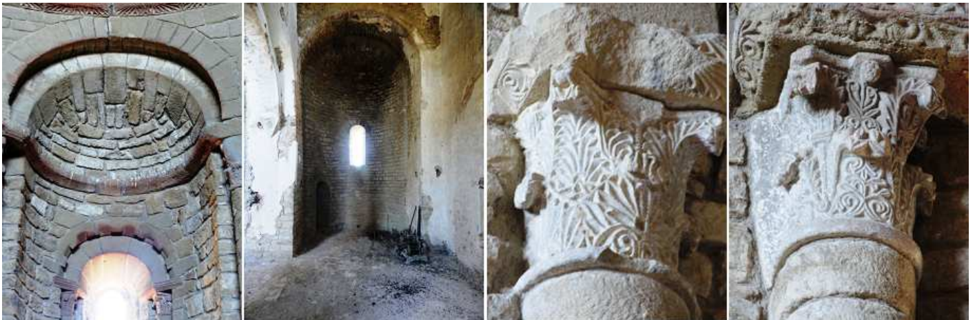
❶ Uno de los arcos del ábside central y su venta con derrame interior. ❷ El ábside del lado epistolar. ❸ Columna adosada redonda del ábside con su capitel. ❹ Capiteles en piedra blanca con filigranas y volutas del ábside. ❺ Otro con distinta decoración, también vegetal.
