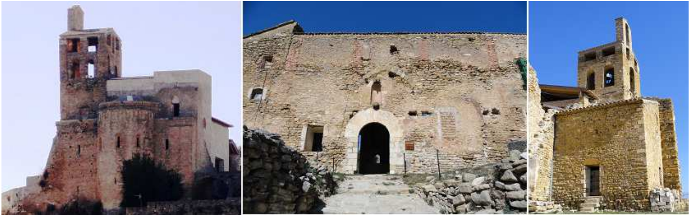
❶ La colegiata desde la carretera. ❷ Entrada al recinto. ❸ Característica torre de San Pedro, culminada por una espadaña. El campanario del S. XII, se sabe por un testamento que en 1094, se encontraba en construcción uno de los dos campanarios que debió de tener la iglesia. Probablemente se trata del campanario que se ha conservado.
