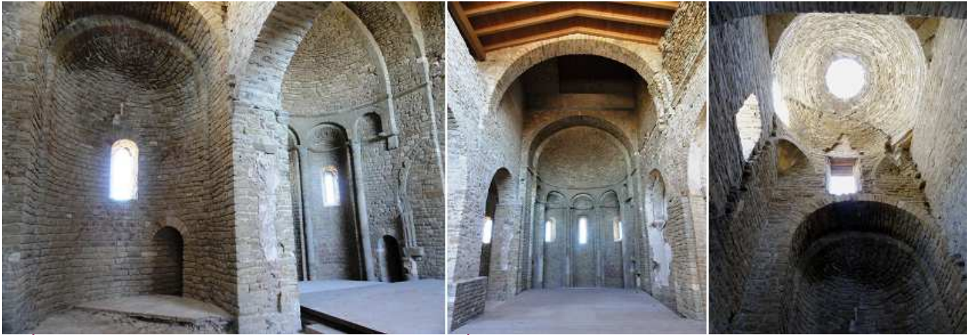
❶ Ábside de lado del Evangelio, abierto con una ventana.. ❷ Ábside central con cinco arcos adosados con columnas que llegan hasta el suelo con sendas ventanas en los tres centrales. ❸ Detalle de la cúpula sobre trompas de la nave del Evangelio.
