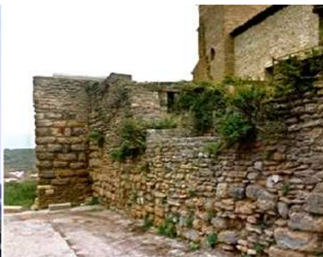
2 Y en la parte posterior de sus ábsides los restos de las murallas.
