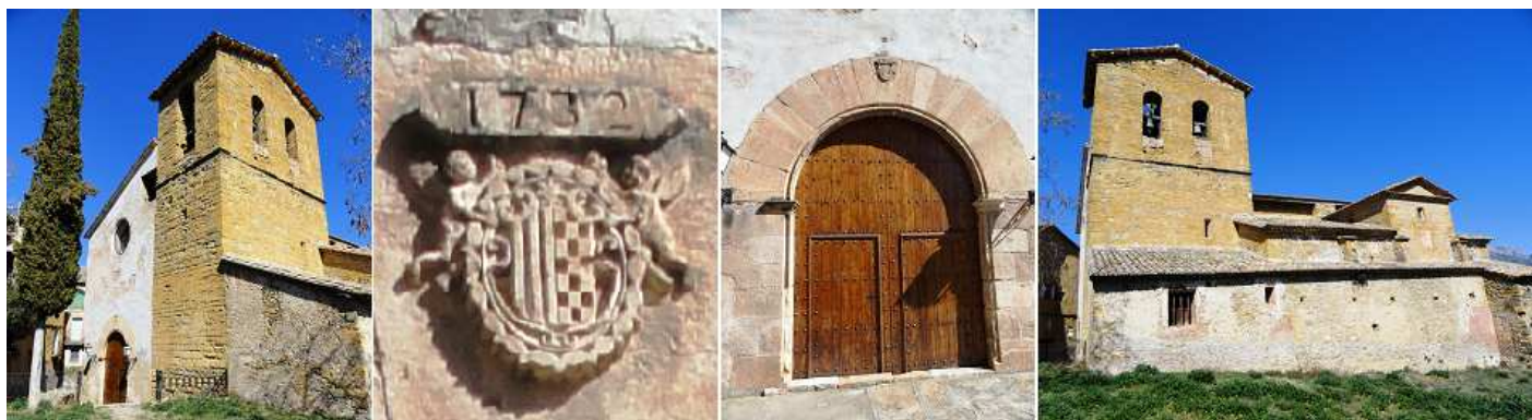
❶ Fachada y torre de San Vicente. ❷ Dovela central de la puerta con la fecha 1782. ❸ Portada de medio punto. ❹ Lateral exterior.
