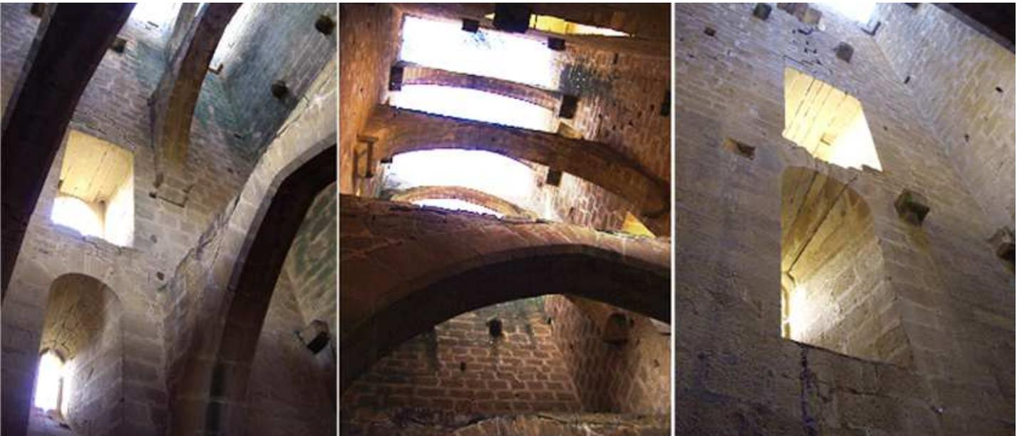
❶ Diferentes imágenes del interior del cubo de la torre. ❷ Los arcos que sostenían el entramado de sus plantas. ❸ Detalle de los gruesos muros en sus ventanales.
