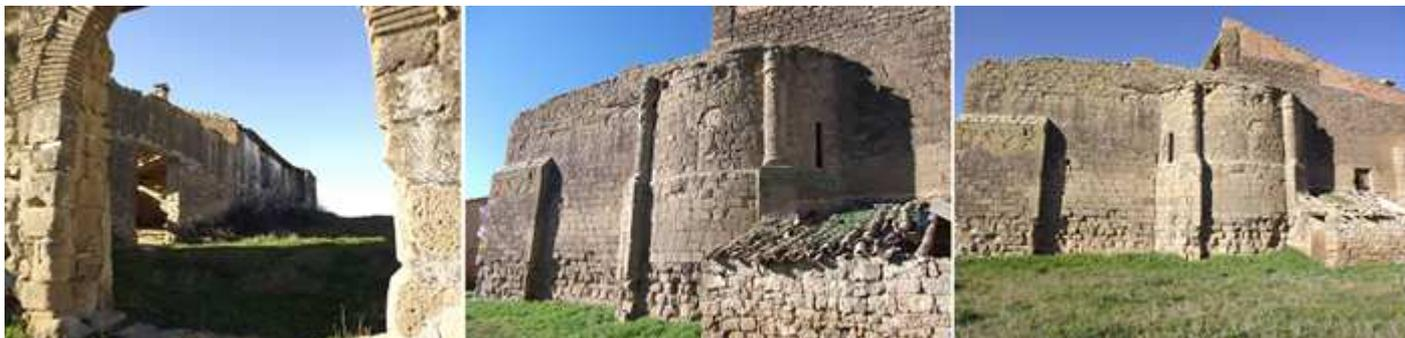
❶ Arco de entrada del muro perimetral parcialmente derruido. ❷ Lateral de la iglesia con una parte de su ábside. Su ábside con una gran basa con dos columnas contrafuertes cuadrados, para convertirse en circulares en la parte superior, y abiertas con tres ventanas de derrame interior, estado la central cegada. ❸ Otra imagen de esta parte del templo.
