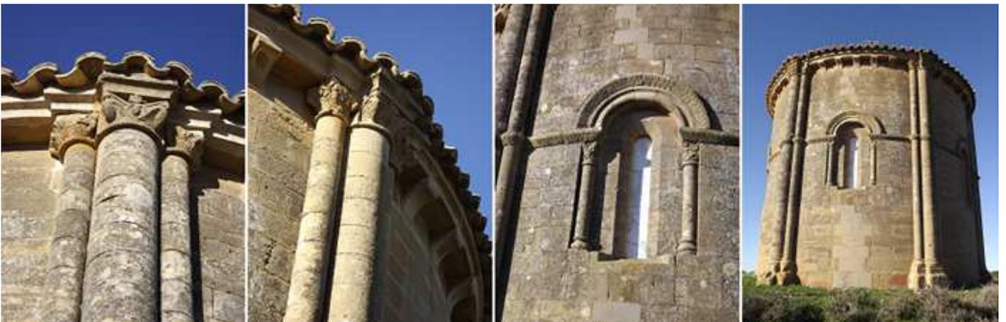
❶ - ❷ Detalle de las triples columnas adosadas en su ábside. ❸ El mismo está abierto con tres ventanas sobre la línea de imposta corrida y su guarda lluvias con la misma decoración que la imposta. ❹ Imagen del ábside.
