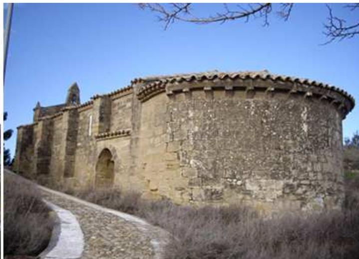
❶ Portada de la ermita con cuatro arquivoltas lisas y coronada con una espadaña de un solo vano. Con arquivoltas de arista viva la interior y exterior y baquetonadas las interiores sobre una imposta corrida. ❷ Parte posterior del ábside y de su puerta lateral. En su exterior se aprecia a los lados de la nave sus contrafuertes y en el de la Epístola su segunda puerta, la cabecera semicircular dispone de una ventana saetera en la parte central y bajo su alero los canecillos son lisos.
