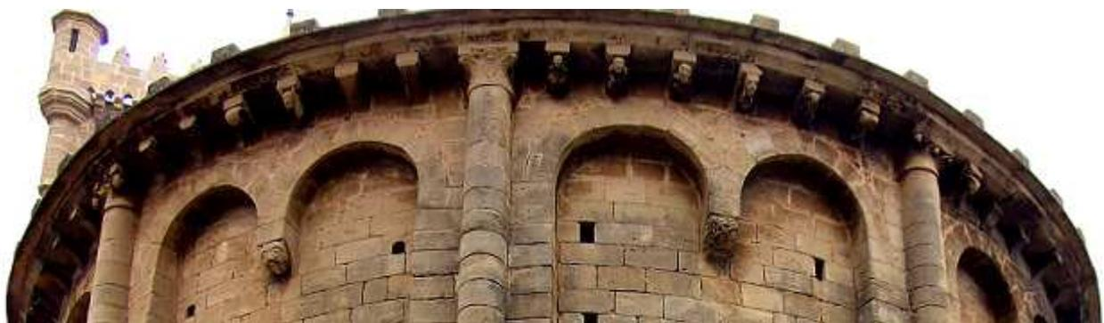
❶ Un variado muestrario de canecillos bajo su alero, y con dobles arquivoltas que descansan en lesenas, y que conforman gruesas columnas rectas, donde esta adosadas otras redondas. Su ábside es lo más destacable de su exterior, muestra cinco calles divididas por pilastras con columnas redondas adosadas con capiteles y su alero esta con canes de diversa decoración.
