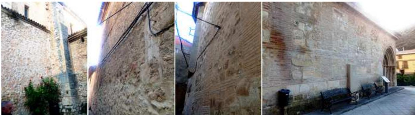
❶ En el exterior de su lado epistolar tiene adosada alguna construcción. ❷ Con su cabecera recta. ❸ En la construcción se aprecia la alternancia del los sillares con la cantería irregular ❹ Y también hay aparejo de ladrillo que forman hiladas.
