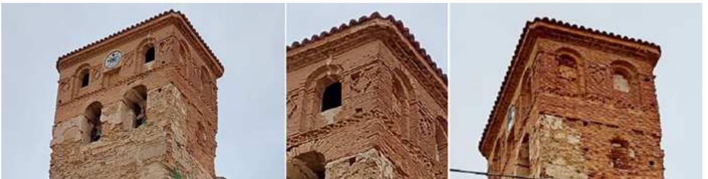
📍 Los dos pisos superiores esta abiertos con arcos de medio en la parte frontal, los inferiores para las campanas. Y sobre los arcos estos el resto está construido en ladrillo con tres ventanales en su frontal (uno cegado que lo ocupa el reloj y dos en los laterales. 📍 Entre ellos dispone de decoración de rombos y de esquinitas en la imposta que separa estos dos pisos y el su alero. 📍 Lateral con los arcos cegados. Foto Ayuntamiento.
