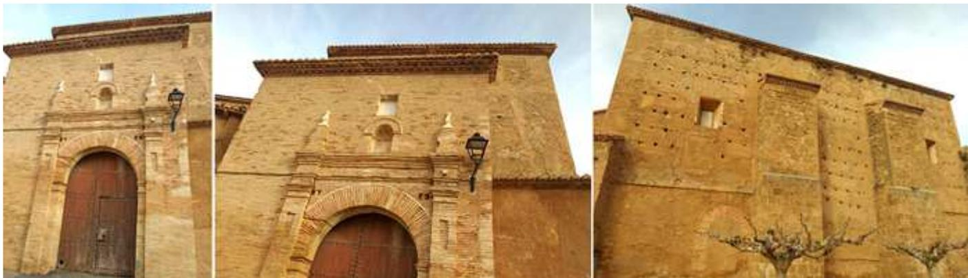
❶ Su portada con columnas recta a sus lados y arco de medio que sobre el entablamento dispone de pináculos y una hornacina vacía, todo el hastial está construido con ladrillos. Se encuentra oblicua al trazado de la nave. ❷ La fachada con un bloque adelanta para su portada. ❸ El lateral de la Epístola posee dos grandes contrafuertes y en el primer tramo de la nave posee una puerta de medio punto cegada. Fotos: Parroquia.
