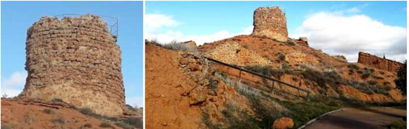
① Esta torre de vigilancia circular con una construcción de sillarejo irregular. Construida tras la conquista cristiana sobre las ruinas de la construcción islámica. ② Localizada en la parte anta de la localidad. Con amplias vistas de 360° en su contorno Fotos Ayuntamiento.
