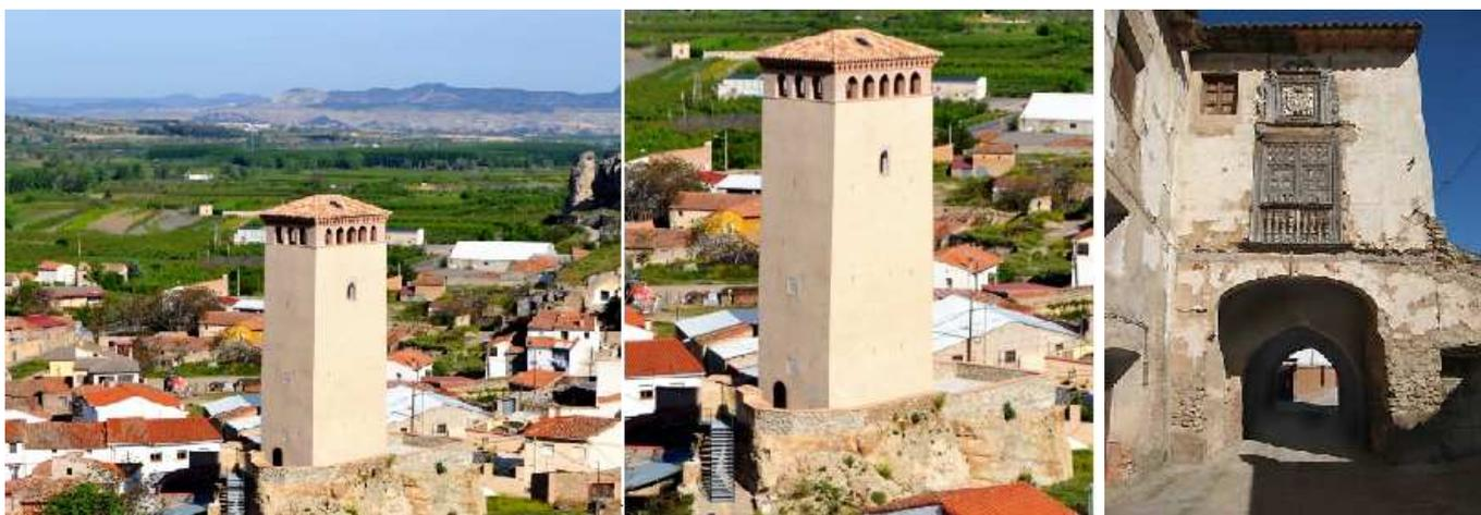
❶ La Torre Albarrana con planta rectangular y cubierta con un tejado a cuatro aguas. ❷ Sobre un peñasco se eleva, mediante una plataforma en su parte inferior, en la superior posee una planta con arquillos típicos de las construcciones aragonesas del S. XV. La rodea una pequeña cerca. ❸ Puerta del S. IV con diversos arcos que poseía un rastrillo, y por su parte interior posee el escudo heráldico de la Casa Ciria del S. XVII. Fotos: Ayuntamiento.
