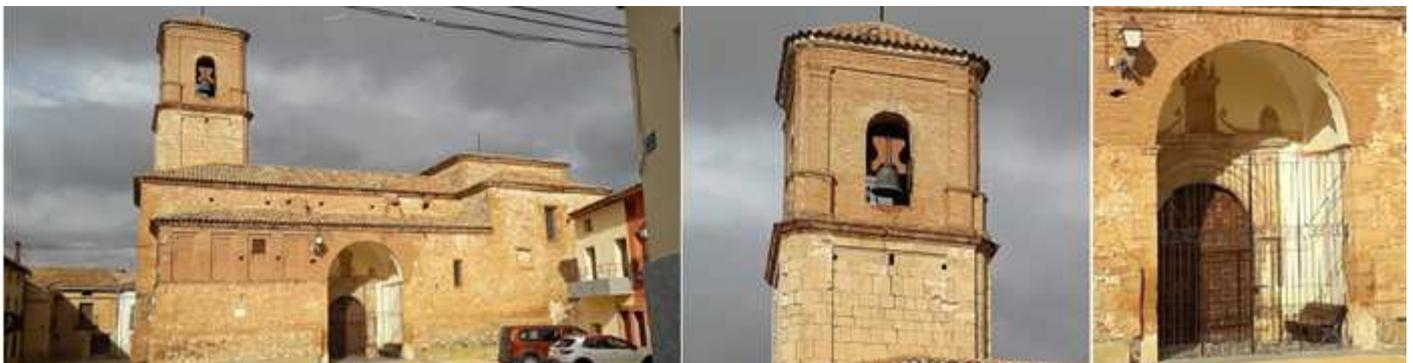
❶ Fachada epistolar del templo donde se aprecian los diferentes periodos de construcción de los materiales empleados, piedra sillar, cantería y ladrillos. ❷ Detalle de la torre en el lado del Evangelio y a los pies del templo. Se compone de tres cuerpos, los dos primeros en piedra sillar y el resto en ladrillo, con ventanas de medio punto y una cubierta a cuatro aguas. ❸ Su portada barroca del S. XVII. Fotos: Ayuntamiento.
