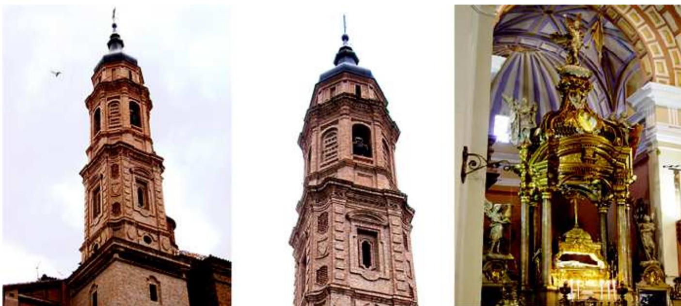
❶ Dos torres dispone el templo en su fachada. ❷ Realizadas en ladrillo con planta cuadrada, que pasa en el cuerpo siguiente a tener sus ángulos ligeramente curvados y los dos últimos de planta octogonal. ❸ Baldaquino del Altar Mayor, sobre seis columnas de mármol, donde está alojado un Cristo yacente.
