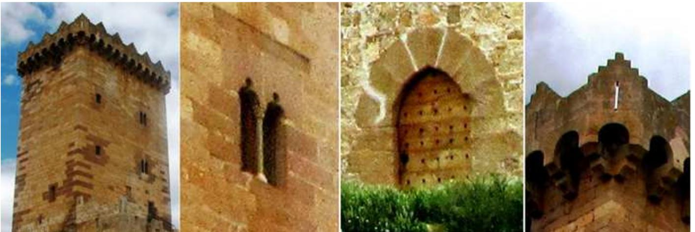
1 En la parte interior de la torre dispone de una ventana adintelada, y otra geminada con arco trilobular con un mainel con un capitel. 2 Detalle de la doble ventana. 3 Su puerta de entrada al castillo con arco apuntado y con sus dovelas lisas. 4 Detalle de un ángulo. Foto: Wikipedia. De Jezhotwells - CC BY-SA 3.0. Aun conserva algunos muros rodeando la torre.
