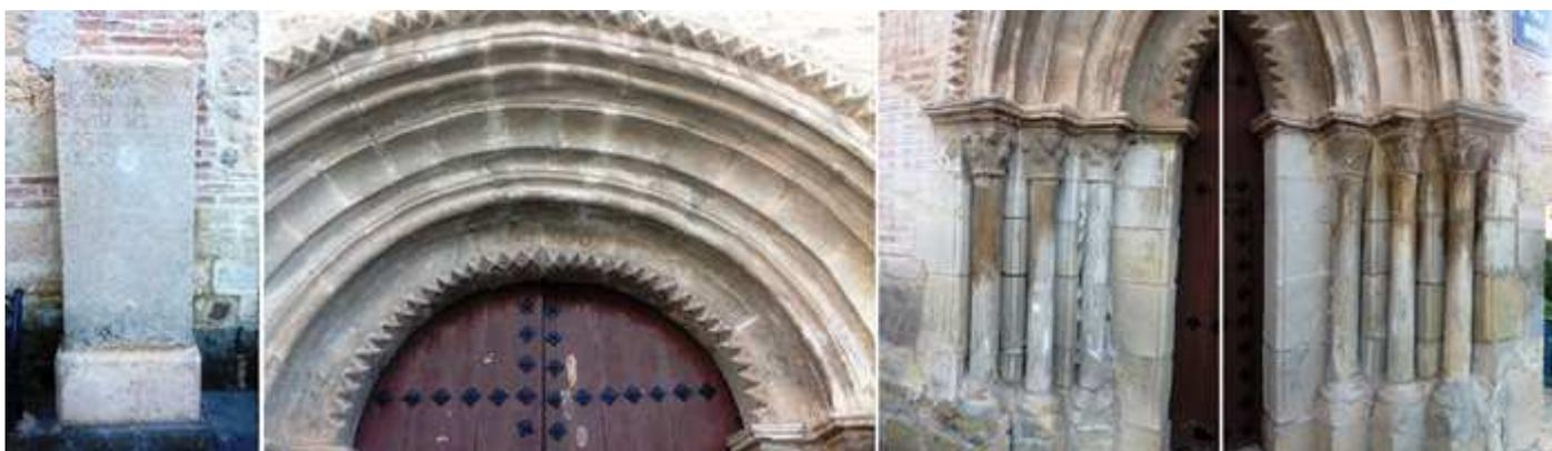
❶ Lada sepulcral de 1619. ❷ Arquivoltas doveladas con una moldura central la interior dispone de puntas de diamante, lo mismo que el guarda lluvias que posee. En la arquivolta interior tiene la fecha de 1798 que sería cuando finalizaría la reforma del templo. ❸ Las arquivoltas descansan sobre una imposta corrida. ❹ Posee tres columnas con sus respectivos capiteles salvo la arquivolta interior que sus jambas son rectas.
