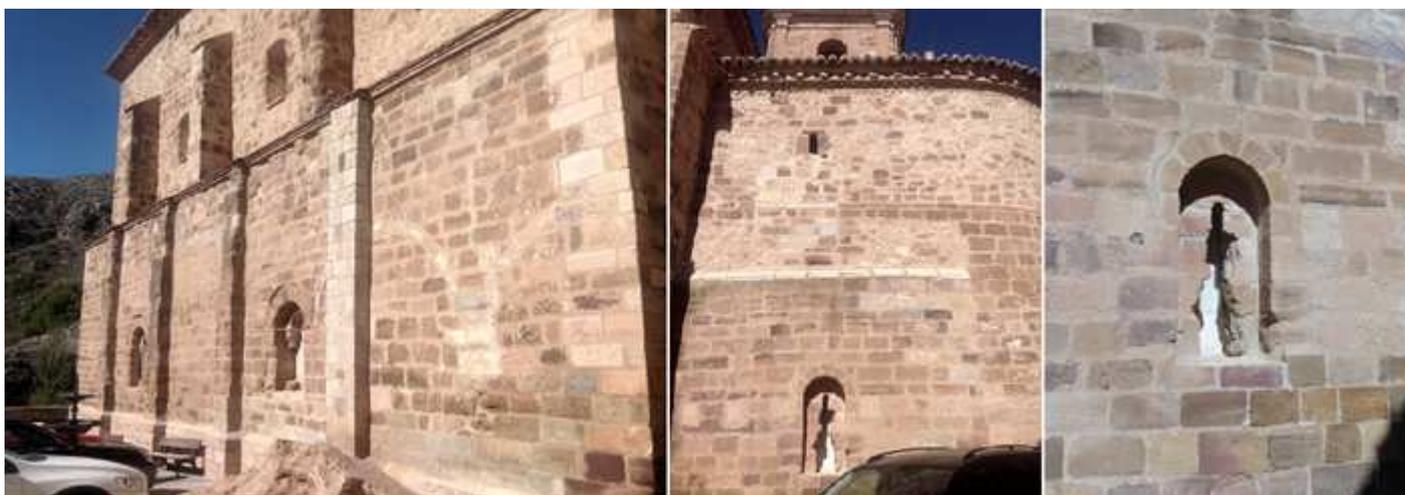
❶ La fachada sur de la iglesia de San Miguel con su parte inferior románica y muy transformada. En ella se abren ventanas doveladas con una arquivolta interior con columnas y capiteles y con un guarda lluvias. En el quinto tramo de la nave se aprecian los rasgos de arcos. ❷ Tramo del presbiterio donde dispone de una tercera ventana de aspillera dentro de un arco. ❸ La citada ventana del lado presbiteral.
