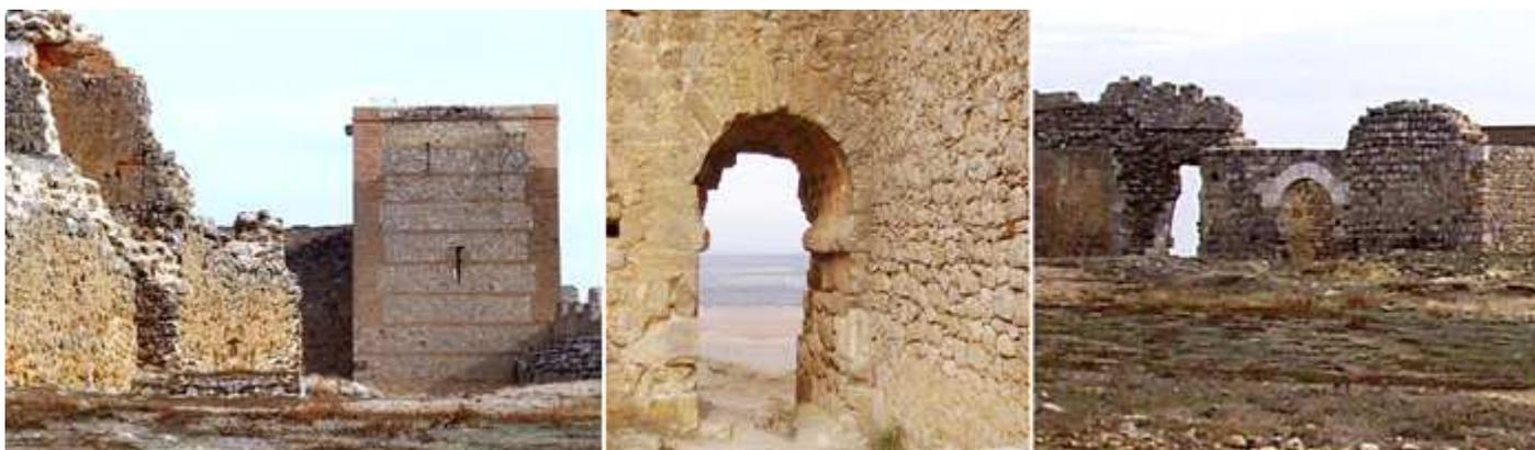
❶ Vista de la torre del Homenaje construida con cantería e hiladas de ladrillo tipo de construcción ya de época cristiana. ❷ Otro vano de herradura. ❸ Parte norte junto a la torre de Almanzor.
