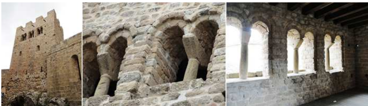
❶ Esta torre estaba unida mediante un puente levadizo con la torre del homenaje, en el tercer piso. ❷ Detalle de las ventanas que posee en el lado sur, con un parteluz. ❸ Interior de la sala con los ventanales.
