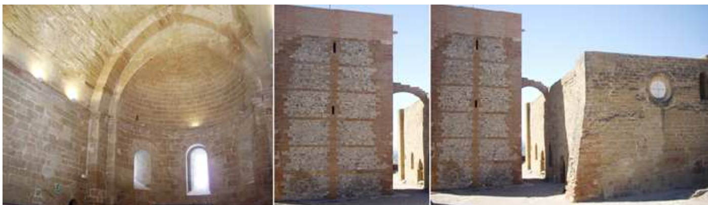
1 Cabecera con el arco triunfal y la bóveda de horno, abierta con tres ventanales con derrame. 2 Lateral este de la torre del Homenaje ante el patio de armas. 3 A su derecha la sala Capitulativa y refectorio.
