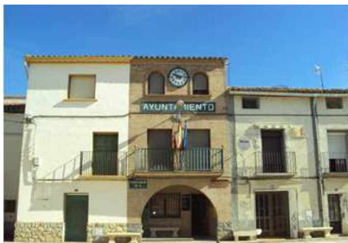
1 Fachada del Ayuntamiento en la plaza Mayor.
