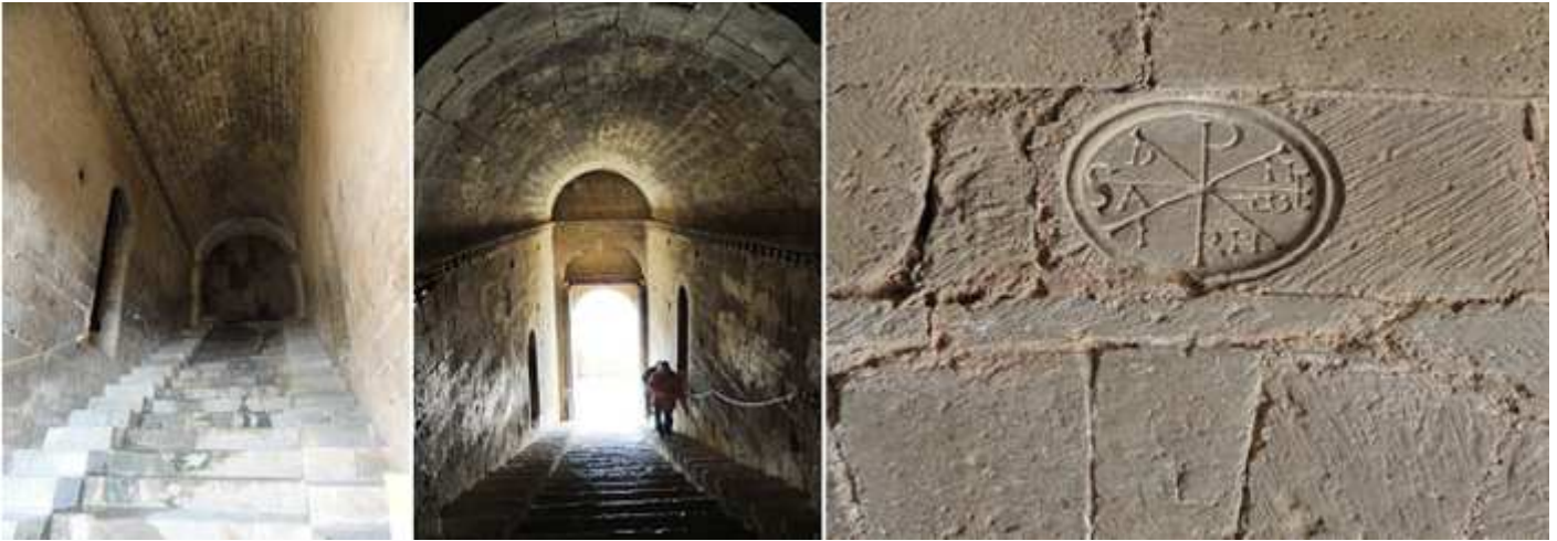
❶ Rampa de escaleras con la separación de las laterales para las personas y la central para las aguas que en días lluviosos desaguaban por la pendiente. La bóveda esta sobre una imposta corrida ajedrezada. ❷ A la izquierda la entrada en la cripta de Santa Quiteria y a la derecha el cuerpo de guardia. ❸ Sobre el arco de entrada a la cripta el crismón antes descrito.
