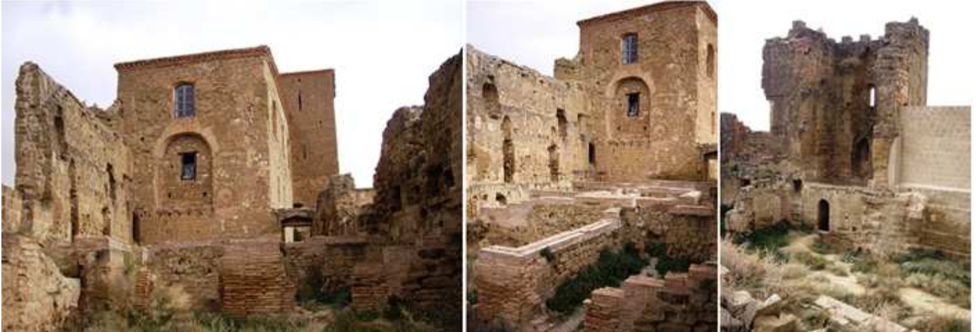
❶ Hastial de la iglesia, bajo el mismo se encuentra la entrada de la cripta. ❷ Los basamentos de los edificios interiores en esta parte ante el templo. ❸ Torre junto a la entrada con recodo por la parte interior del castillo.
