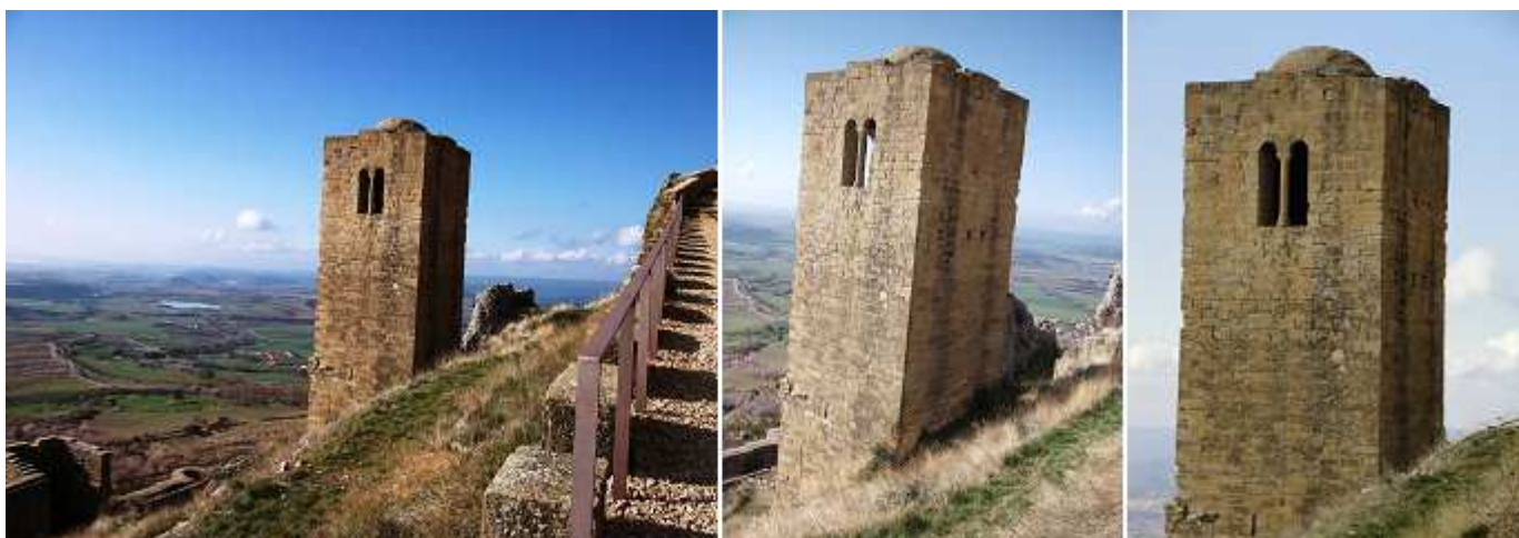
❶ Torre albarrana, llamada del vigía. De planta cuadrada y exenta del S. XI. Cada lado mide 5m. ❷ Torre que cumplía la función de defender la puerta del castillo que tiene en frente. También ha tenido el uso de campanario. ❸ Dispone de dobles ventanas en tres de sus caras. En las proximidades de la misma existe una necrópolis, mejor dicho dos que se diferencian por la calidad de los enterramientos.
