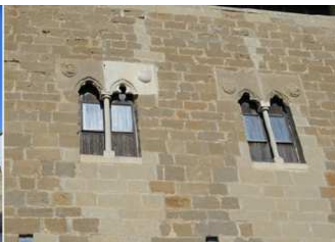
1 Fachada sur con dos ventanas geminadas con arcos trilobulares y mainel en la planta noble, en la parte inferior ventanas adinteladas más pequeña y debajo de aspillera. 2 Detalle de las ventanas que sus ángulos superiores ostentan los escudos nobiliarios. 3 Una de sus ventanas de la parte superior.
