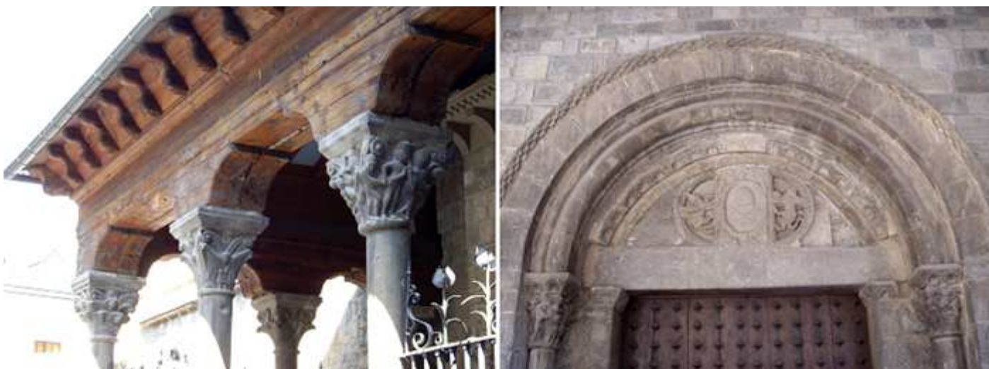
① Acceso lateral o sur, con bellísimos capiteles. Y donde se encuentra la vara "jaquesa" que se utilizó como medida. ② Portada Románica que sobre el dintel ostenta un tímpano que muestra la tiara papal y los símbolos de San Pedro.
