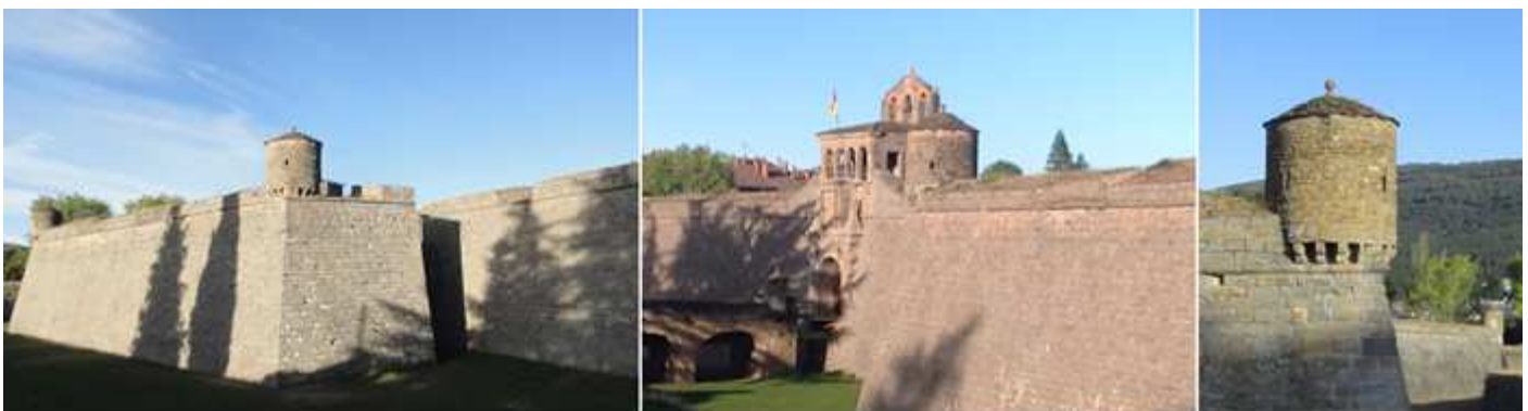
❻ Baluarte de la izquierda con recodo. ❼ El puente que su último tramos era elevadizo para quedar incomunicada la ciudadela. ❽ Carita del baluarte derecho de esta parte frontal.
