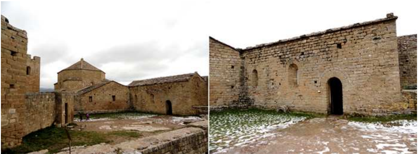
❶ La plaza de armar con el cimborrio de la cúpula de la iglesia de San Pedro. ❷ Lateral de la capilla con una sencilla puerta de medio punto y dos ventanas de aspillera con derrame exterior, todos estos vanos no poseen decoración.
