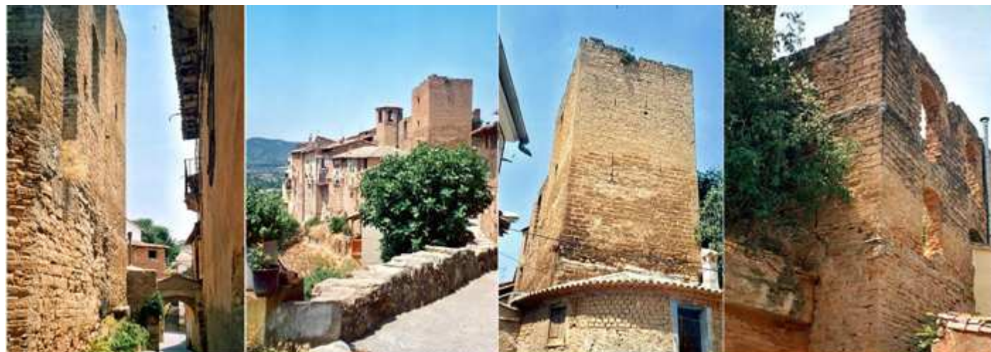
1 Detalle de la puerta con el arco. Tras ella estaría la plaza de armas lo que hoy día es un patio triangular. 2 La torre se compone de tres plantas abierta con saeteras y una puerta en altura por la que se accede desde el primer piso del palacio. almenas. 3 No
