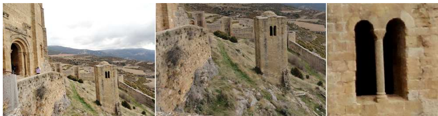
❶ Perspectiva en este lado de la ladera ❷ Entre la puerta y la muralla la torre del vigía o albarraña. Es de planta cuadrada de tres pisos, y se divisaba perfectamente la puerta de los Reyes. ❸ En su exterior cuenta con dobles ventanas de medio punto.
