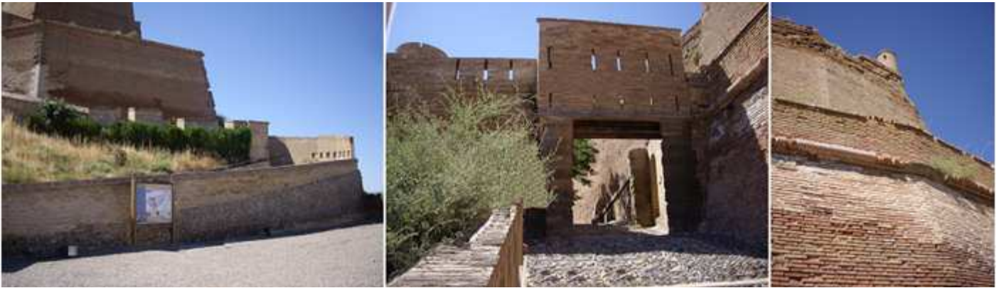
❶ Batería de las Horcas S. XVIII. ❷ Segunda puerta protegida con muros abiertos para la fusilería. ❸ Desde la explanad de las Horcas la considerable altura de los muros del castillo.
