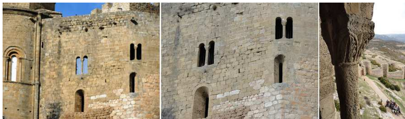
❶ En las habitaciones de los pabellones de la zona nordeste de su exterior nos muestra unas ventanas ajimezadas. ❷ En esta parte de la muralla que une la torre a su derecha con el ábside de la iglesia se aprecian diferentes periodos de este cerramiento por el color de sus piedras. En la parte inferior ventanas de medio punto tipo aspillera con gran derrame exterior y una línea superior con ventanas dobles con un mainel o columna con capiteles decorados. ❸ Ejemplo de uno de los capiteles con hojas.
