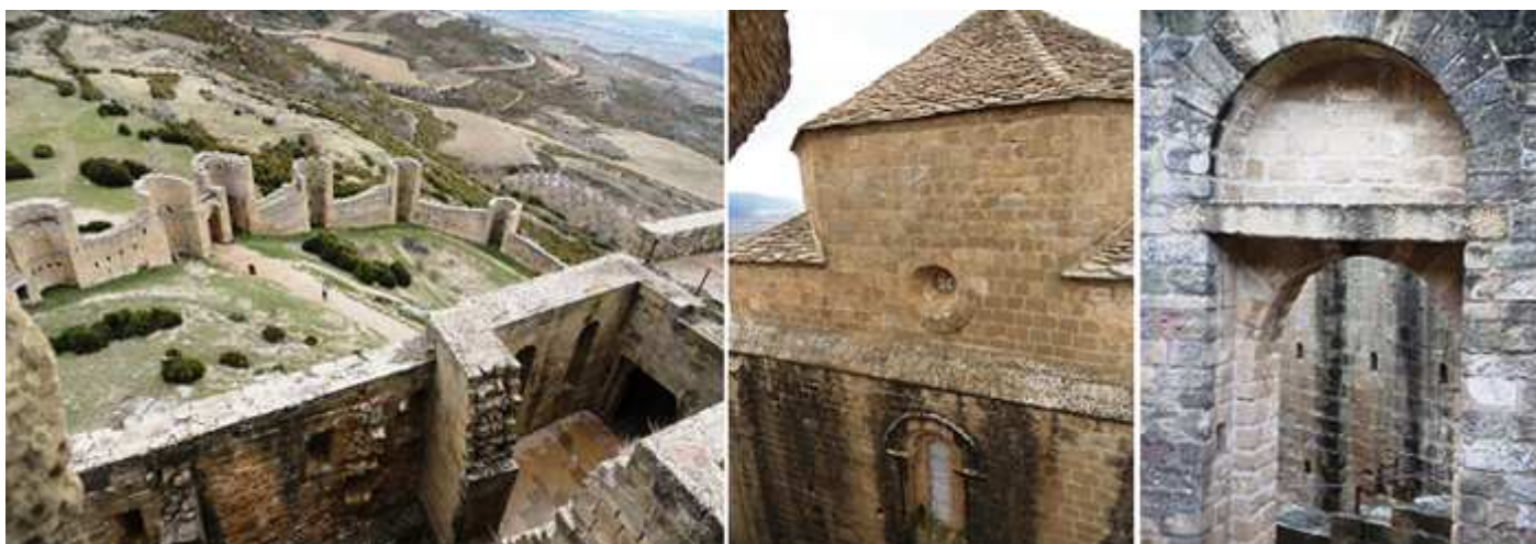
❶ A su alrededor las murallas exteriores del castillo con vistas de la sierra y de la Sotonera. ❷ Parte exterior del crucero, con una ventana con arquivolta y guardapolvo taqueado, el óculo antes de iniciarse sus cúpula. ❸ Una de las puertas (del castillo lombardo) en la salida hacia las escaleras bajo la iglesia.
