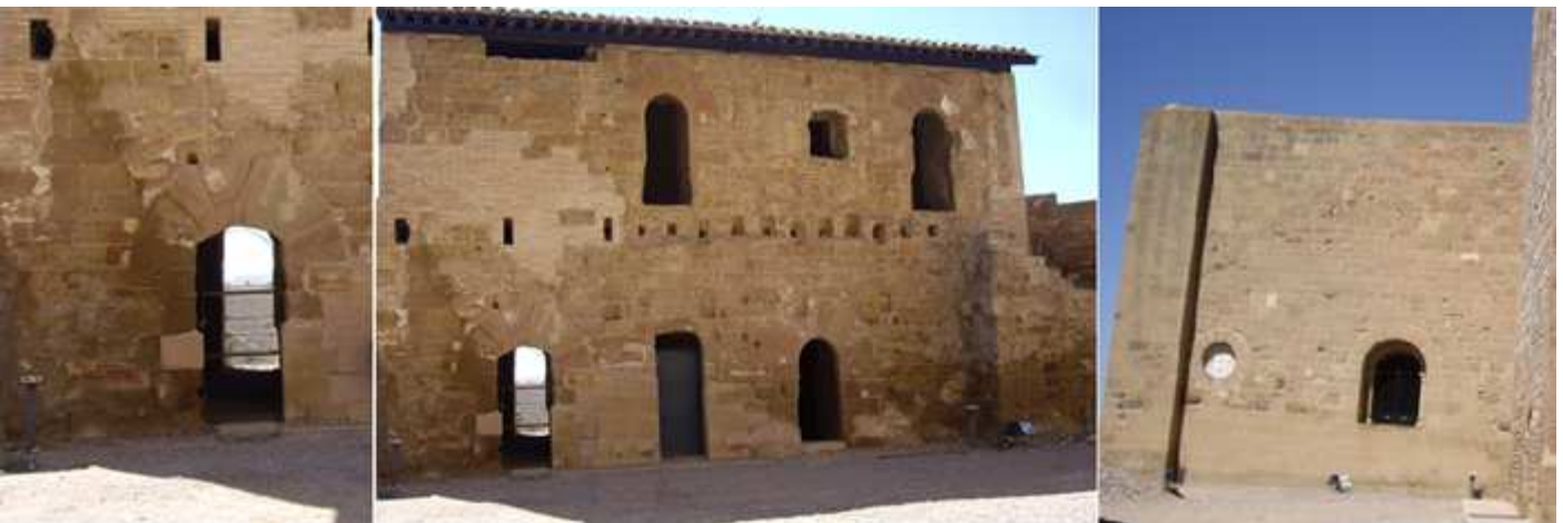
❶ En este edificio que su parte exterior da al precipicio había dependencias de los monjes. ❷ En el que tenían dormitorios. ❸ Facha lateral del edificio de la Sala Capitular con óculo y una de sus ventanas, en sus bajos existe uno de los aljibes.
