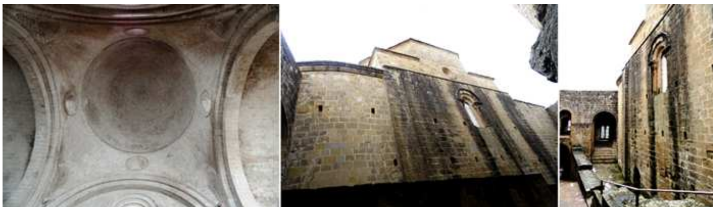
❶ La cúpula del crucero con sus óculos, trompas y el casquete semiesférico. ❷ Lateral exterior del lado del Evangelio en este templo de San Pedro. ❸ En la parte del tramo del crucero obsérvese el arco de las escaleras que atraviesan el templo por su subsuelo.
