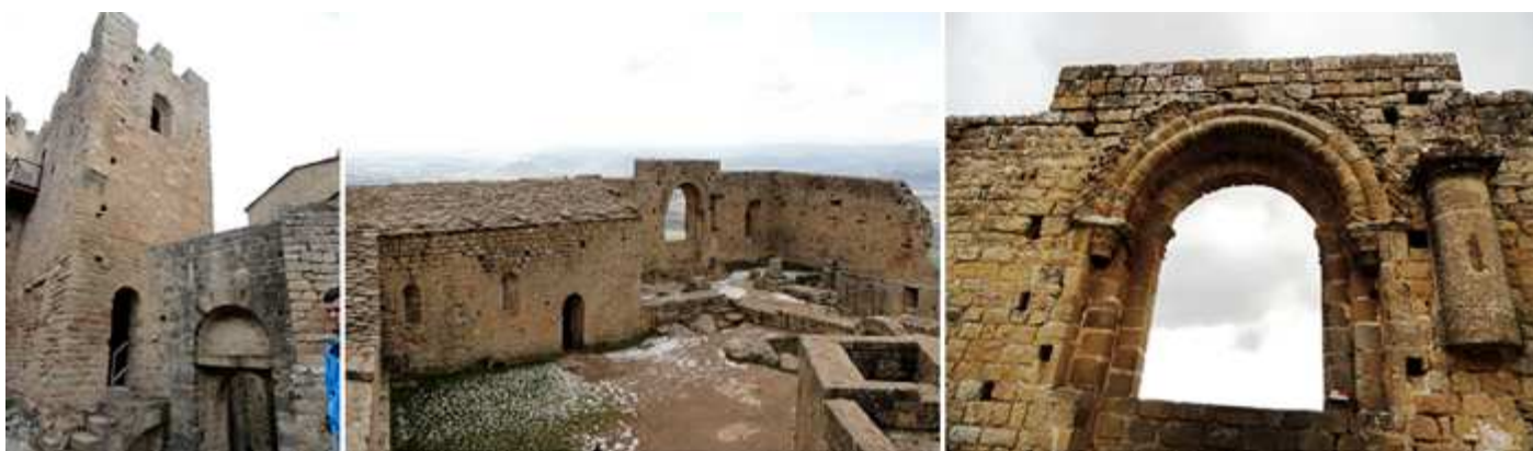
❶ Tras las visitas de las torres bajamos al patio de armas. ❷ Vista del patio de armas y a la izquierda la antigua capilla. ❸ Balcón de la Reina
