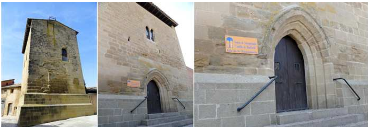
❶ Fachada noreste con su base en forma de talud. Y con una cubierta a dos aguas. ❷ Fachada principal. ❸ Con su puerta de arco apuntado con tres arquivoltas, y una grada de escaleras ante ella.
