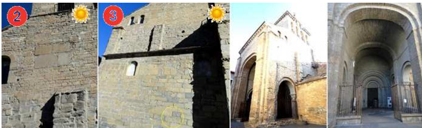
❶ En la fachada sur de la catedral de San Pedro el 2º. Tipo: horizontal, rectangular. Con los números y horas excavados. Orientación al mediodía Traza: de las 6 a las 7 h. p.m. en números arábigos. Gnomon de varilla con inexistente. Estado: sobre el mismo se aprecia una dualidad de trazos y horas, al haber sido corregido. ❷ Más abajo el 3º. Traza: solo se conservan unos rasgos apenas perceptibles y el orificio de gnomon. ❸ Pórtico de la fachada principal añadido en la reforma del S. XVI. ❹ Con arcos de medio punto rebajados y bóveda de cañón alberga su puerta oeste.
