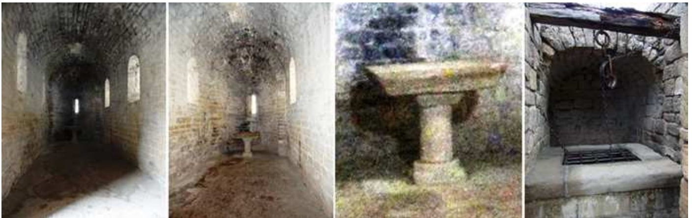
❶ La estrecha nave de la capilla cubierta con bóveda de cañón. ❷ Cabecera con un arco triunfal y las ventanas también con derrame interior. ❸ Sencilla de altar en la cabecera. ❹ Brocal rectangular del pozo o aljibe que estaba cubierto. En este castillo el agua valía por vino, expresión de de la defensora del castillo en 1413 Violente de Luna.
