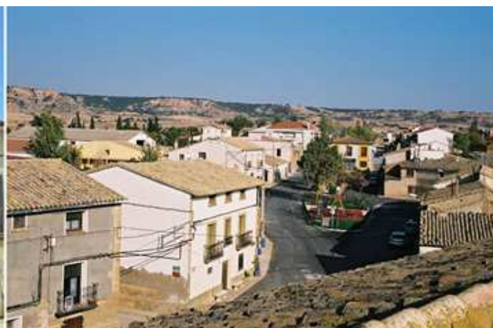
2 Avenida del Parque. Fotos Ayuntamiento.
