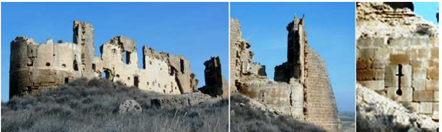
② Sobre este promontorio se encuentran las ruinas de lo que queda de esta construcción defensiva. ③ Cubo del este y un contrafuerte a su derecha, ④ Aspillera en cruz. Fotos: Francisco Bolea (SIPCA – www.sipca.es )
