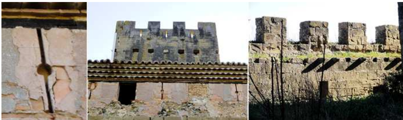
❶ Tipo de Saetera de "palo y orbe" bajo el alero del palacio. ❷ Alero confeccionado con 4 filas de tejas. ❸ La muralla en la parte oeste desde la puerta de entrada dentro de la propiedad.
