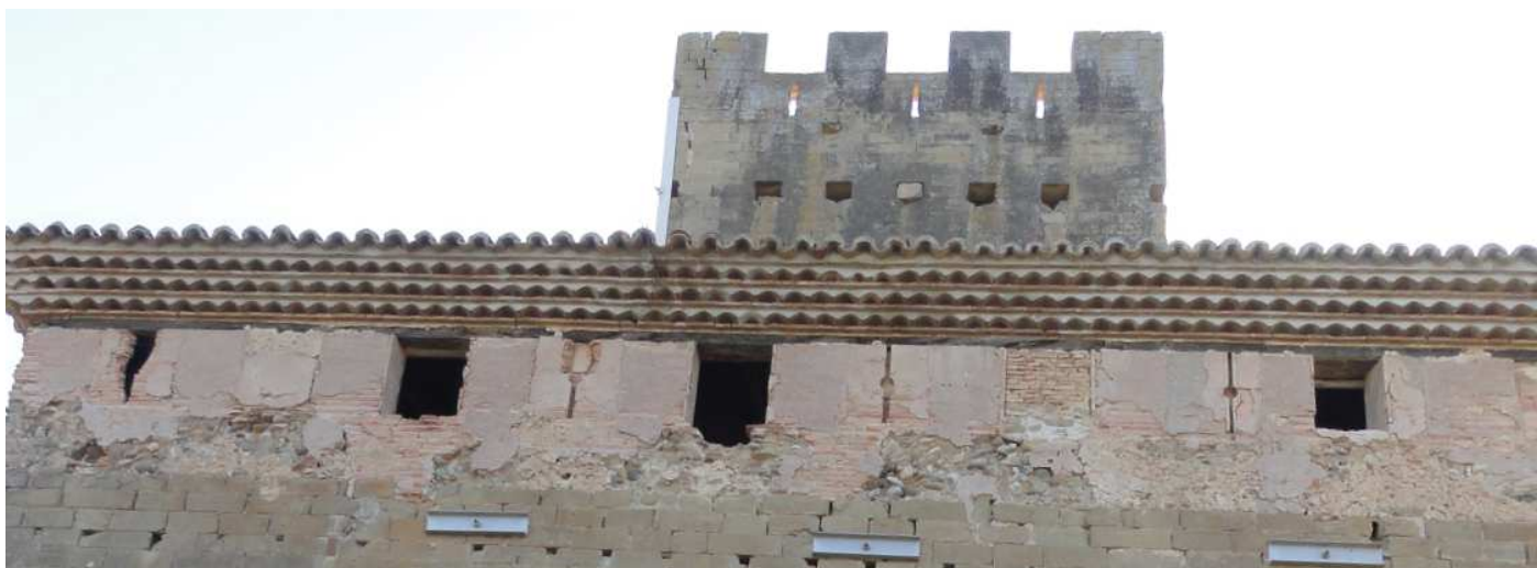
❶ La parte superior del palacio, con un recerimiento de una falsa que rodea la torre realizada con argamasa y ladrillo y que está dotada con aspilleras de palo y orbe y posteriormente se han abierto ventanas adinteladas. Anteriormente esta parte estaba dorada con almenas.
