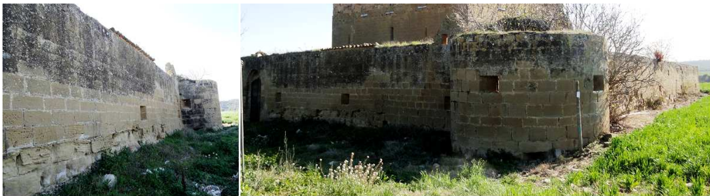
❶ La muralla sur. Desde la puerta de entrada al torreón que posee a su derecha. ❷ En este ángulo sur posee este torreón circular que en su parte interior posee un pozo de agua.
