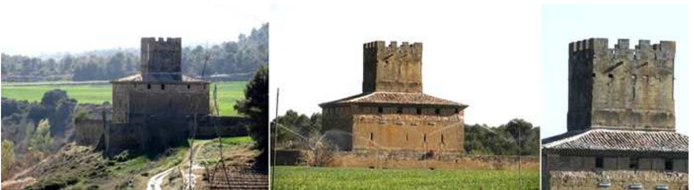
❶ Vista del castillo desde la carretera, antes de cruzar la presa con el río bajo nuestros pies que nos separa. ❷ El conjunto se compone de la primitiva torre que está envuelta por el palacio construido en torno a ella en el S. XV-XVI. ❸ La torre central con planta cuadrada de 7 m de lado y 15m de altura y con estancias abovedadas.
