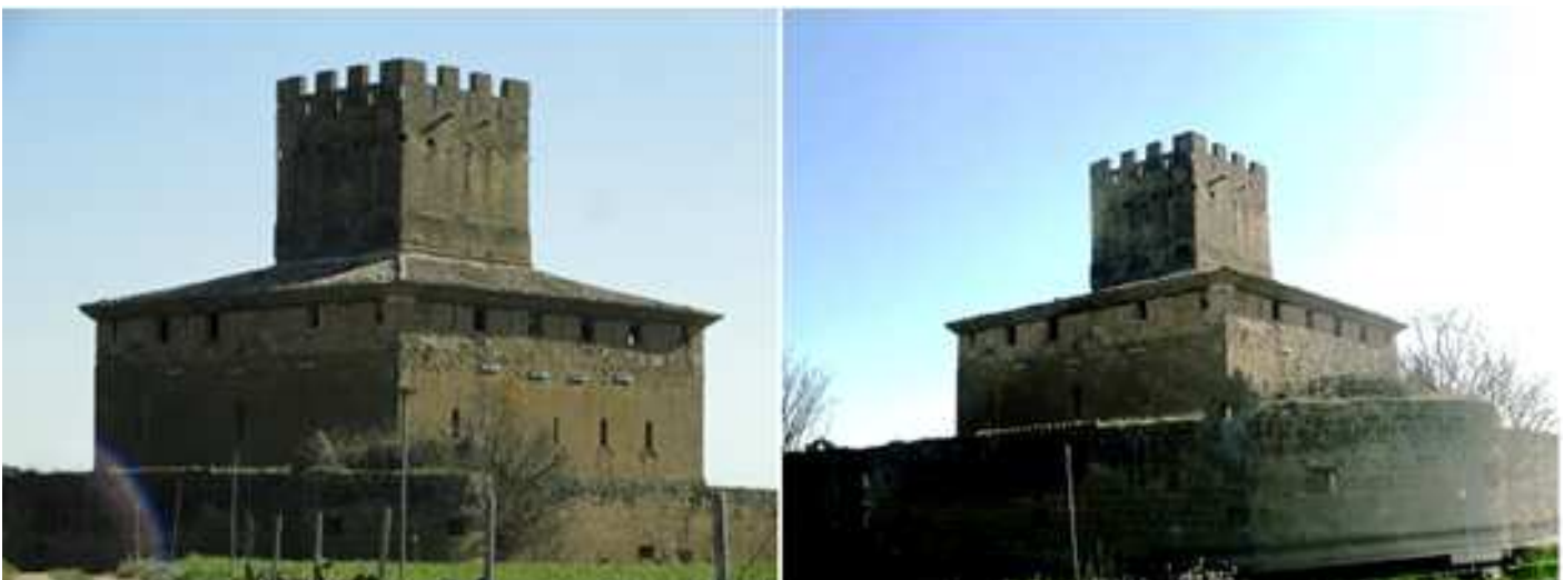
❶ Todo el conjunto está rodeado de murallas también de forma cuadrada. ❷ A la derecha de su entrada y fortaleciendo su puerta y camino de acceso, dispone de un torreón de planta redonda con troneras.
